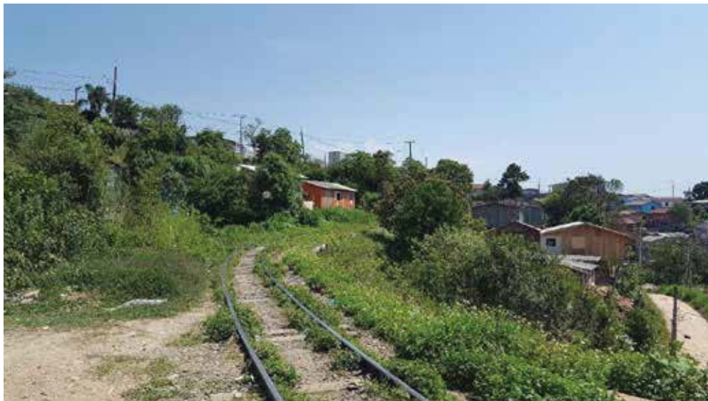
Fotografia 3 – Casas com ocupações na faixa de domínio na área crítica
