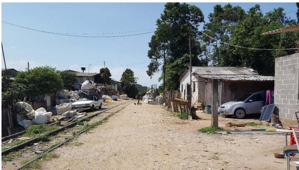
Fotografia 1 – Casas com ocupações na faixa de domínio na área crítica
