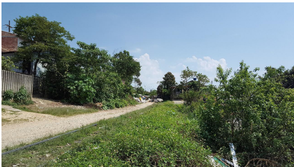
Fotografia 2 – Casas com ocupações na faixa de domínio na área crítica
